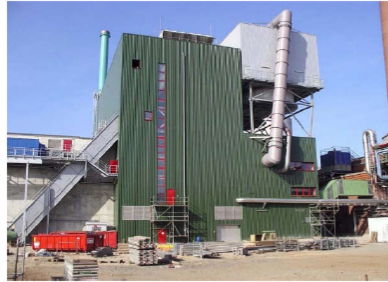
Mainova Fechenheim / D - 2006 44 MWth (66 bar, 450°C) waste wood, RDF
